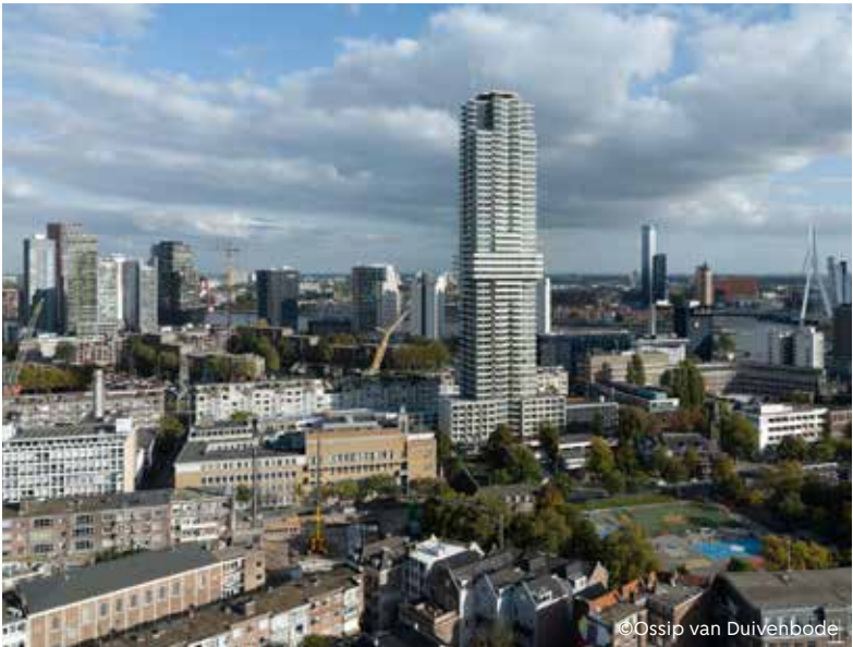
inspiratie: Cooltoren, Rotterdam, V8 Architects De draagstructuur van deze toren bestaat uit een stabiliteitskern met kolommen daaromheen. Door kolommen in plaats van dragende wanden te gebruiken, is de indeling van de plattegrond makkelijk aan te passen in de toekomst.
